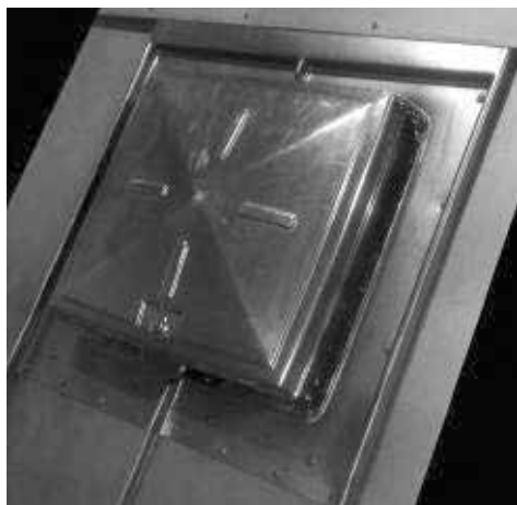
Kattoluukku asennettuna.
