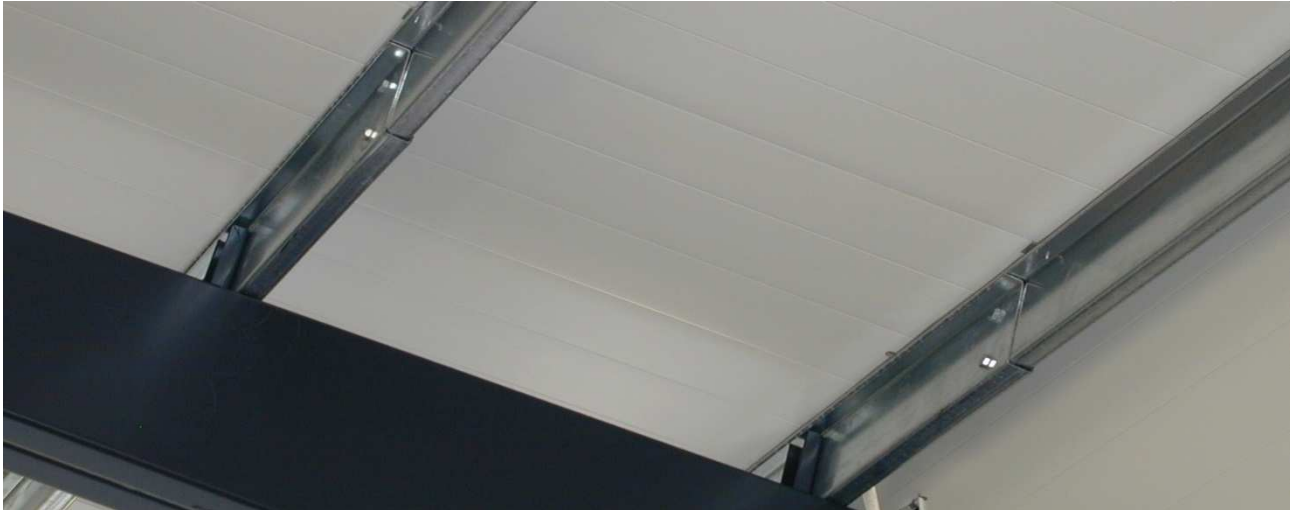
Kuva 5. Z-orret Kattoelementtien kannattajina.
