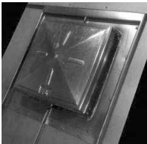
Kattoluukku asennettuna.
