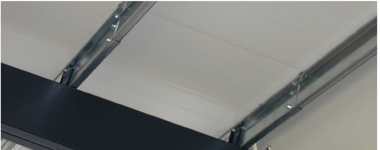
Kuva 5. Z-orret Kattoelementtien kannattajina.
