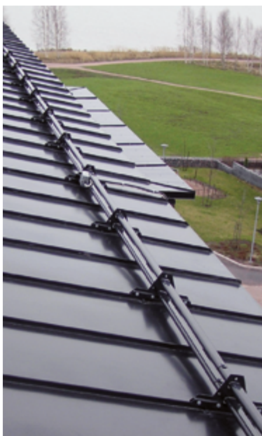
Lumieste on Suomen oloissa välttämätön tuote kulkureittien kohdalla. Kattosiltaja voidaan käyttää myös työtasojen ja porrasaskelmien rakentamiseen katolla.
