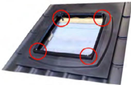
Kuva 45. Pohjaosan kiinnitys ruoteisiin, holkkien läpi ruuvatuilla ruuveilla
