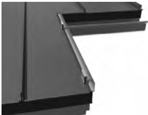
Kuva 28. Aluslista ja sivukiinnikkeet asennettuina
