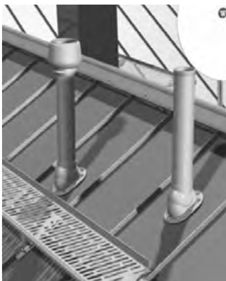
Kuva 39. Läpivientielementtien sijainti lappeella.
