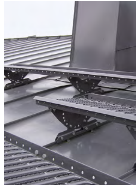
Lumieste on Suomen oloissa välttämätön tuote kulkureittien kohdalla. Kattosilloja voidaan käyttää myös työtasojen ja porrasaskelmien rakentamiseen katolla.
