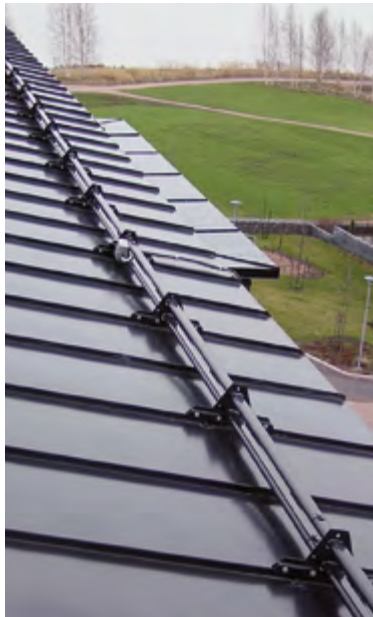
Lumieste on Suomen oloissa välttämätön tuote kulkureittien kohdalla. Kattosilloja voidaan käyttää myös työtasojen ja porrasaskelmien rakentamiseen katolla.
