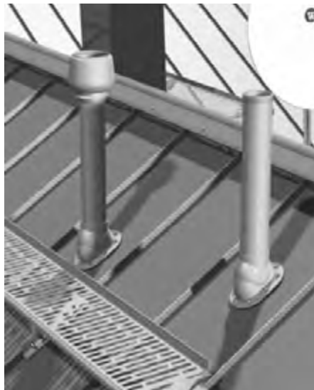
Kuva 39. Läpivientielementtien sijainti lappeella.
