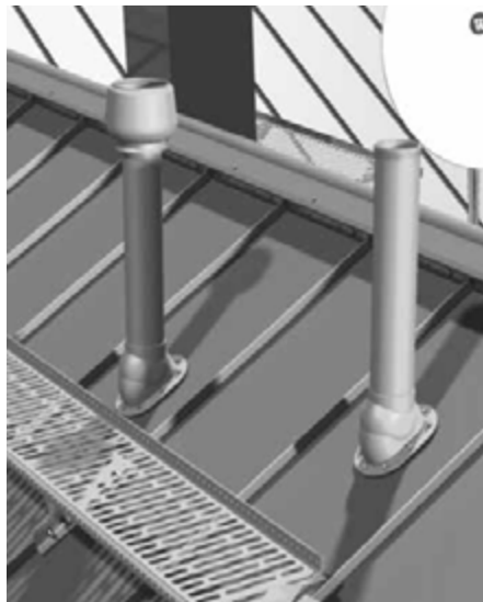
Kuva 39. Läpivientielementtien sijainti lappeella.
